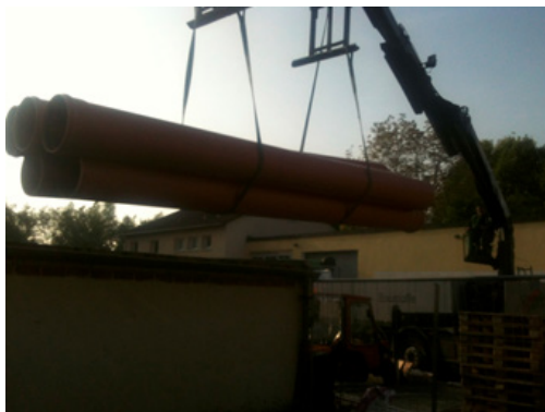
Anlieferung der 6m Kanalrohre auf unserer Arbeitsfläche
