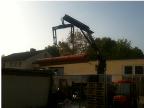
Anlieferung der 6m Kanalrohre auf unserer Arbeitsfläche
