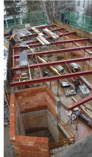
Während der Bauphase: Neues Treppenhaus und neues Dach
