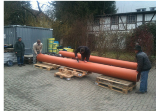
Der Arbeitskreis in Aktion. Durchtrennen der Kanalrohre.
